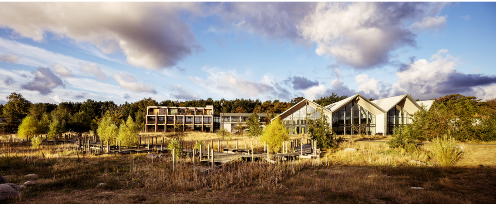
Duński hotel GSH na wyspie Bornholm ma być pierwszym budynkiem o ujemnym poziomie emisji CO 2 . Do jego realizacji przewidziano wykorzystanie m.in. drewna klejonego krzyżowo, wyeliminowano potrzebę wentylacji mechanicznej, a elementy budynku nadają się do ponownego wykorzystania w przyszłości, fot. Adam Mork / 3XN
