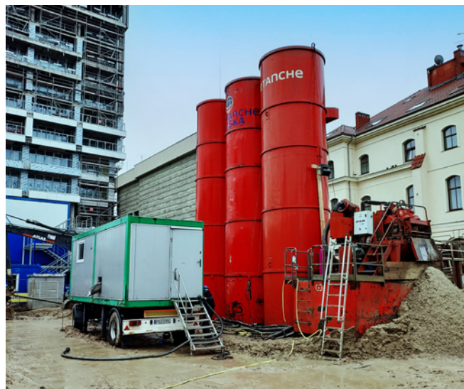
Regeneracja płuczki bentonitowej
