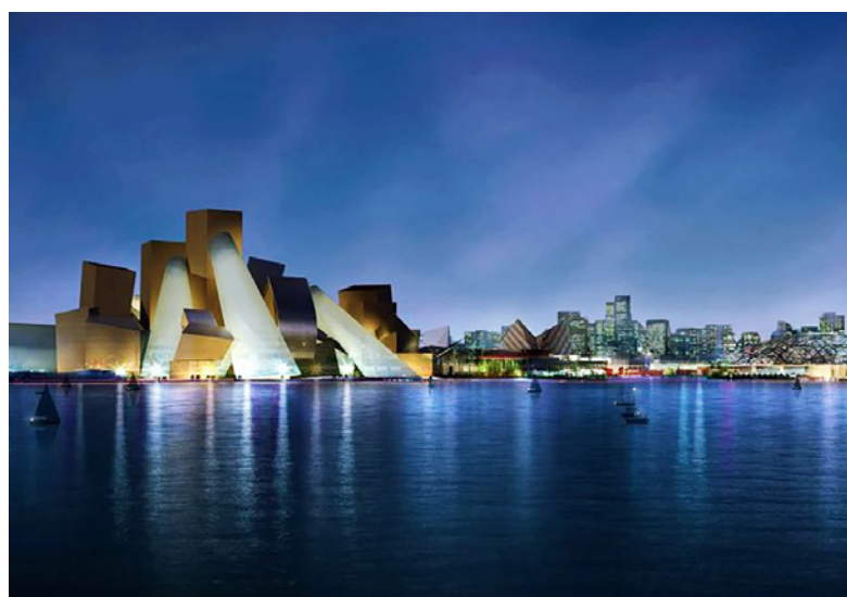
Nowatorskie Muzeum Guggenheima w Abu Zabi – w przebiegu inwestycji BIM został wykorzystany do projektowania i symulacji budynku, koordynacji oraz zarządzania budową i logistyką. Po zakończeniu budowy będzie używany do zarządzania i konserwacji systemów oraz wyposażenia budynku przez cały cykl jego życia, wizualizacje Frank Gehry / Guggenheim Abu Dhabi
