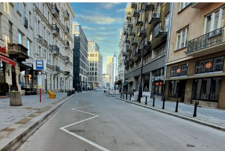
Betonowa nawierzchnia ul. Szpitalnej w centrum Warszawy, zbudowana w 2021 r.
