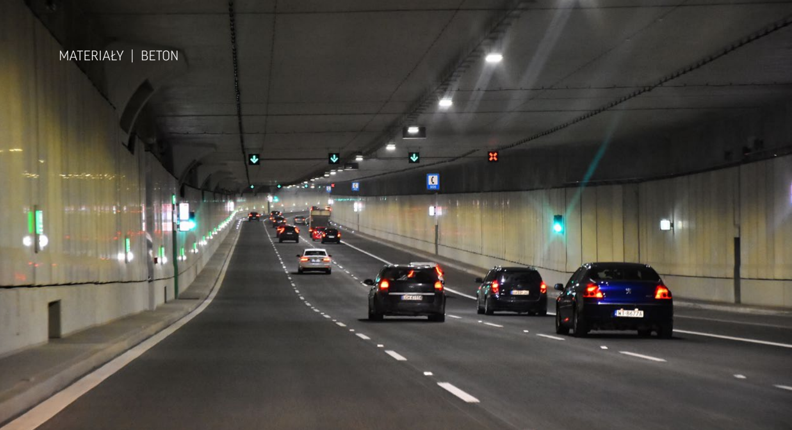
Tunelem pod Ursynowem w ciągu drogi ekspresowej S2, w ciągu niespełna 4 miesięcy przejechało ponad 5 mln pojazdów. W tunelu jest nawierzchnia betonowa
