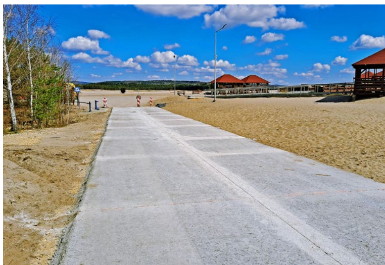
Droga z betonu wałowanego prowadząca na Pustynię Błędowską, zbudowana w 2021 r.
