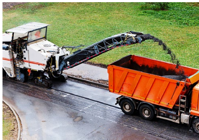
Frezowanie nawierzchni drogowej
