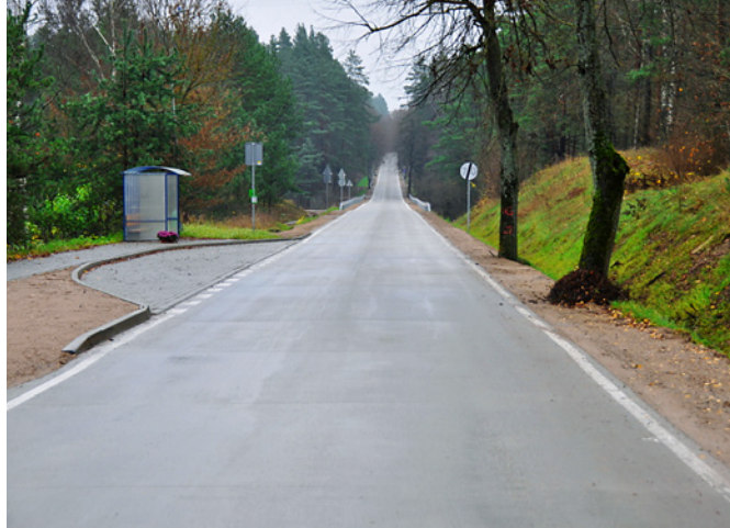
Powiatowa droga betonowa w gminie Elk, fot. Starostwo Powiatowe w Elku
