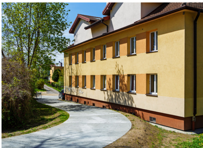
Skawina – betonowe ciągi pieszo-rowerowe, fot. UMIG Skawina
