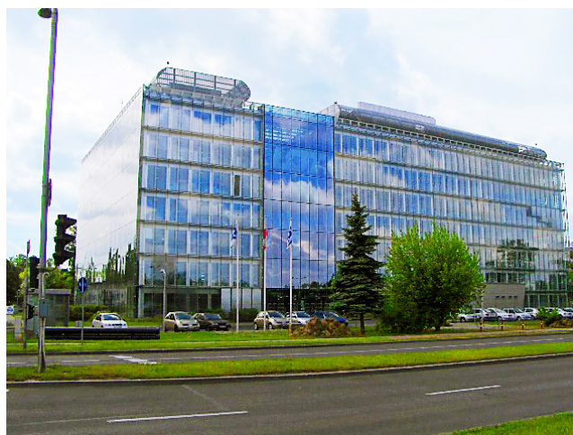
Budynek biurowy PLL LOT w Warszawie, źródło: materiały własne Keller Polska
