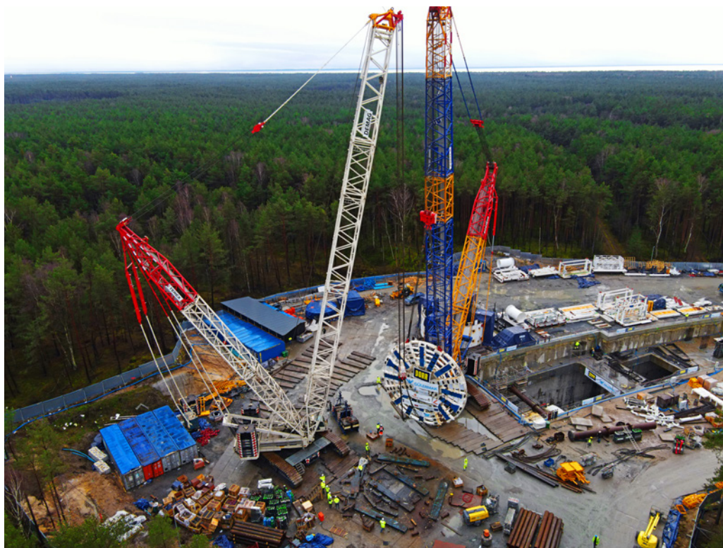
Budowa tunelu w Świnoujściu, fot. PORR SA
