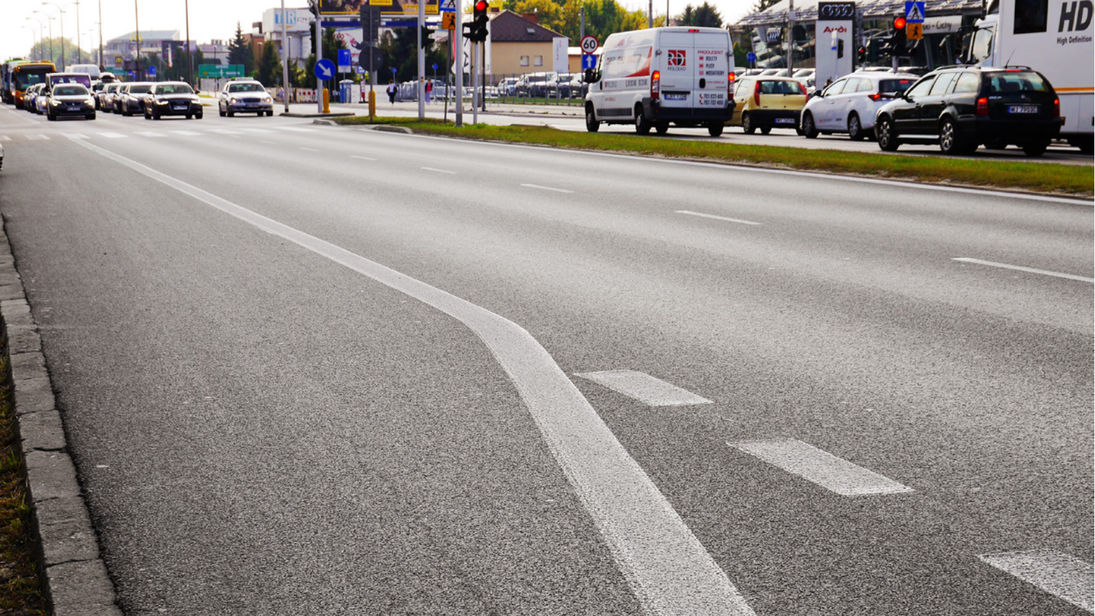
Modbit 45 80 80 zastosowany w Warszawie
