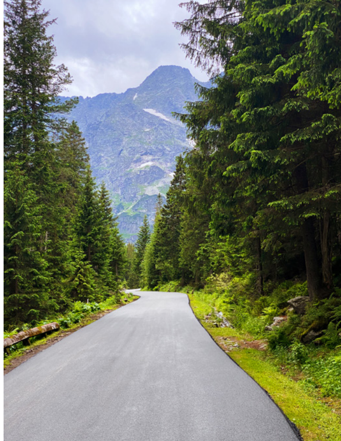
Nawierzchnia na szlaku nad Morskie Oko – asfalt WMA
