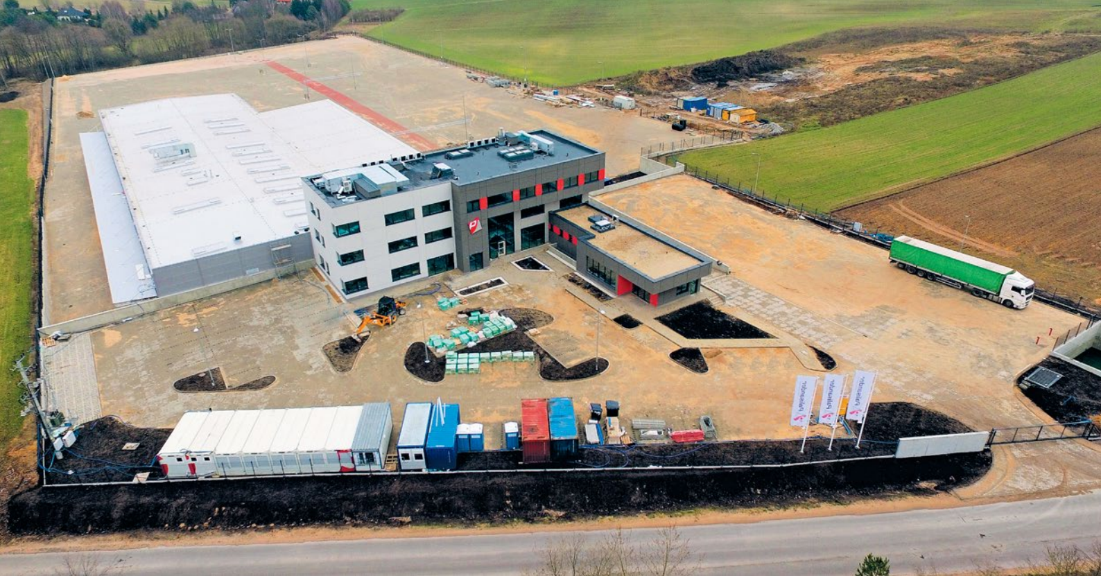
Nowe Centrum Logistyczne Palisander na ukończeniu
