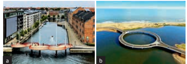
Ryc. 8: a) kładka dla pieszych Cirkelbroen, Kopenhaga, Dania, L = 40 m, otwierana część środkowa 25 m, 2015, maszty z odciągami nie są elementami konstrukcji, pełnią rolę dekoracyjną (np. przez wywieszanie flag), co trochę burzy ład strukturalny obiektu, b) okrągły most drogowy, jezioro Garzon, Urugwaj, R = 51,5 m, 2015
