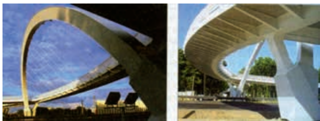
Ryc. 14. Stalowa kładka dla pieszych z pomostem kompozytowym nad drogą S11 w Gądkach koło Kórniku, L = 241,45 m, l_{\text{mas}} = 40,00 m, 2007 [42]
