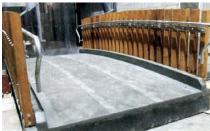
Ryc. 13. Mostek wykonany z ultrawysokowytężalnego betonu z kruszywem szklanym [39]
