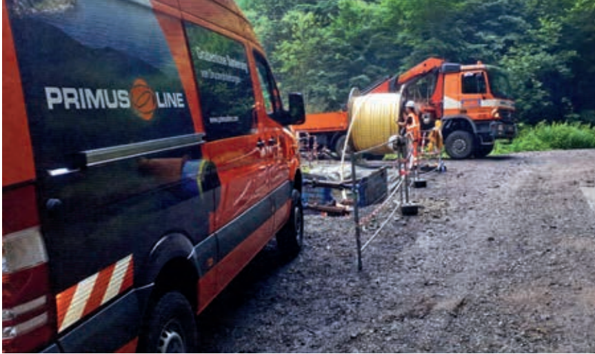
Ryc. 2. Przeprowadzenie rehabilitacji gazociągu w trudno dostępnym obszarze leśnym
