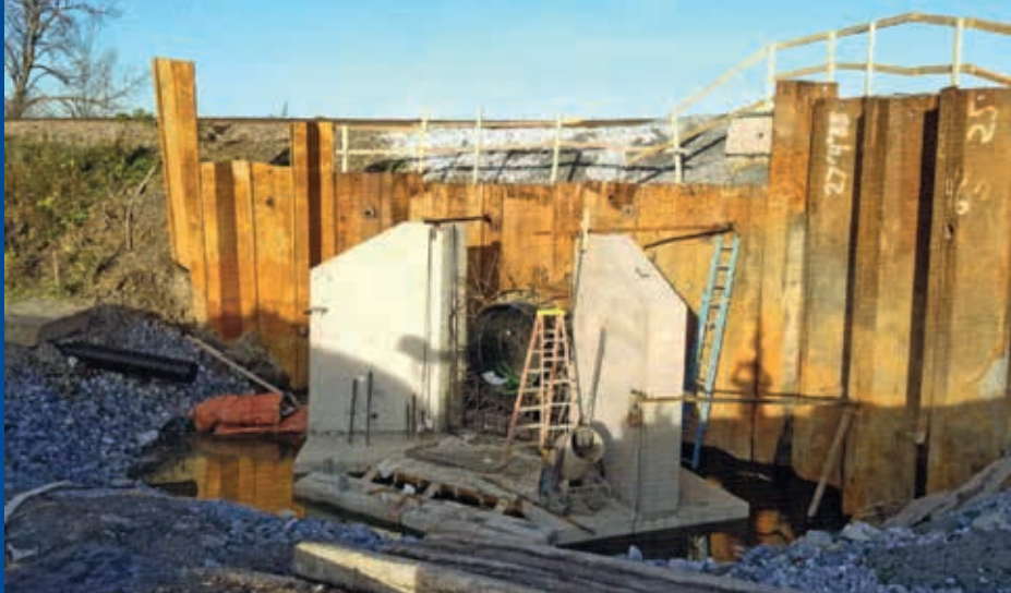
Ryc. 1. Przepust pod torami kolejowymi na etapie wbudowania
