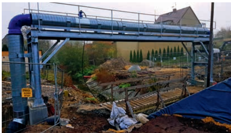
Rury do instalacji nad ziemią przy przejściach przez mosty, w tunelach – preizolowane rury typu WKG
