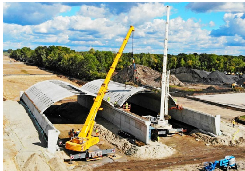
Ryc. 5. Montaż metodą leaf by leaf
