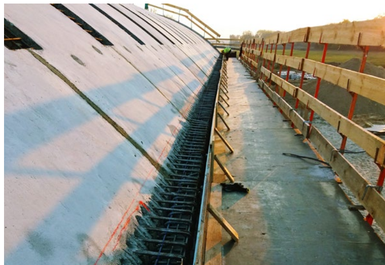
Ryc. 7. Zabetonowane zamki w kluczu prefabrykatów
