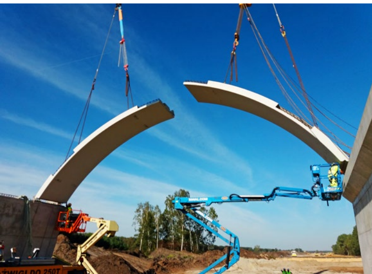
Ryc. 4. Montaż metodą leaf by leaf
