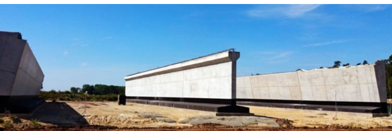
Ryc. 2. Zakończony podpory obiektu, przygotowane do montażu prefabrykatów
