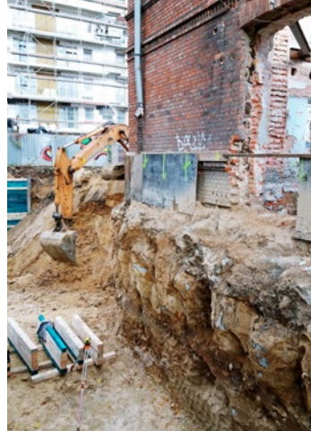
Odstonięte komuny wykonane w technologii jet grouting
