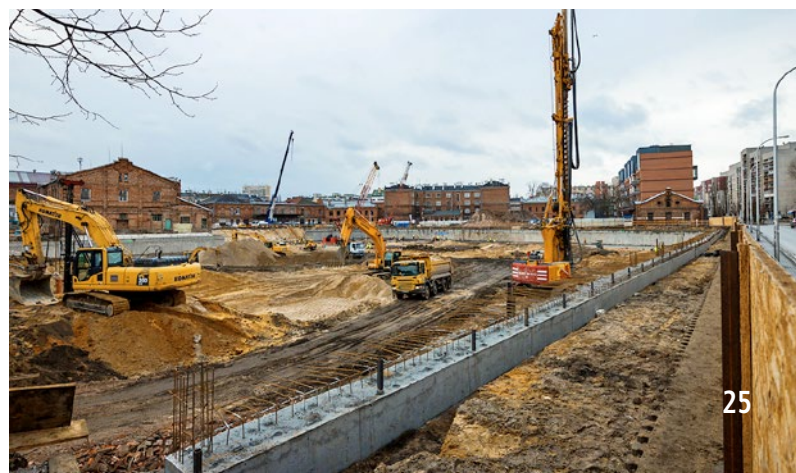
Realizacja ścian szczelinowych garażu podziemnego pod Centrum Praskim Koneser
