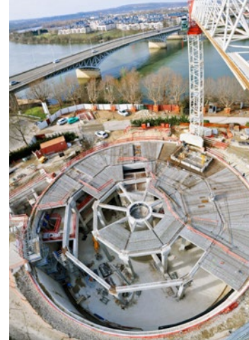
Budowa zbiornika magazynowego Poissy Bridge o pojemności 8100 m 3
