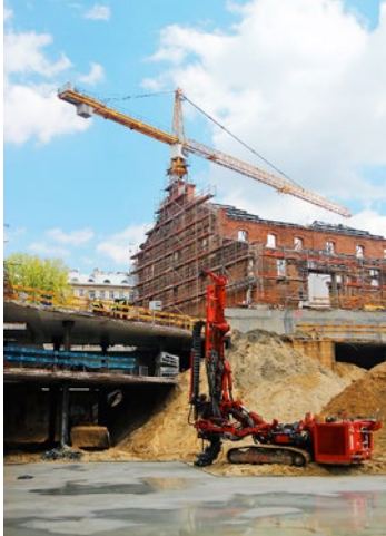
Wykonanie mikropali kotwiących płytę fundamentową garażu podziemnego pod Centrum Praskim Koneser
