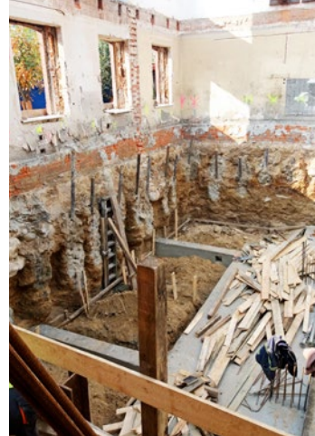
Kolumny jet grouting wewnątrz budynku
