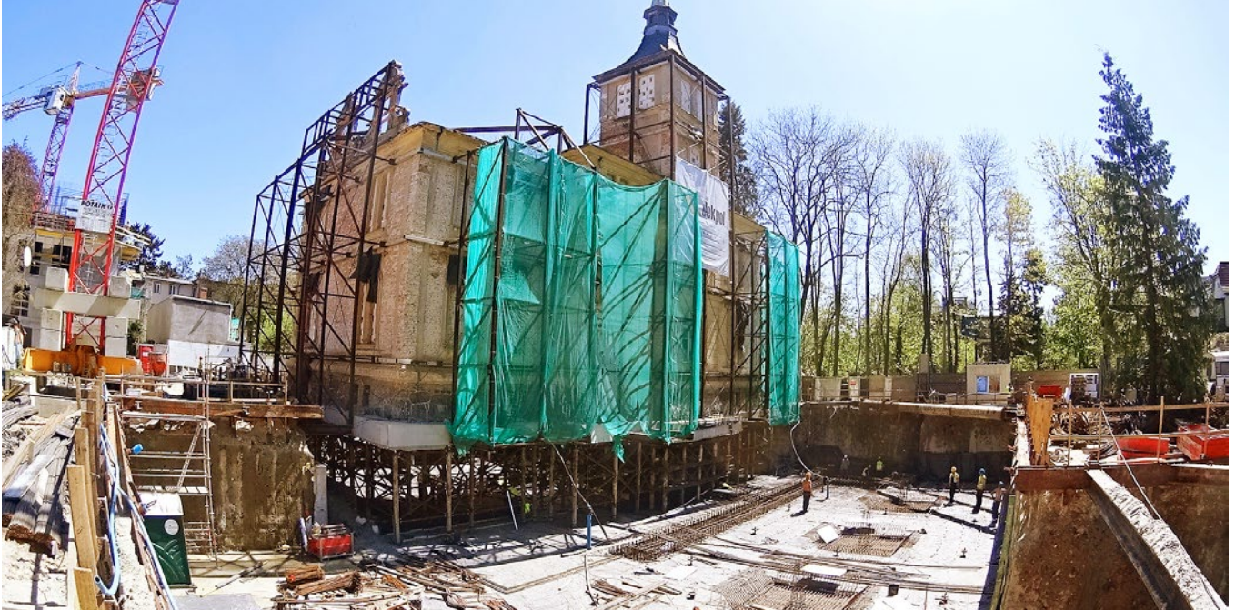
Wykonanie fundamentów oraz parkingu podziemnego pod istniejącym budynkiem
