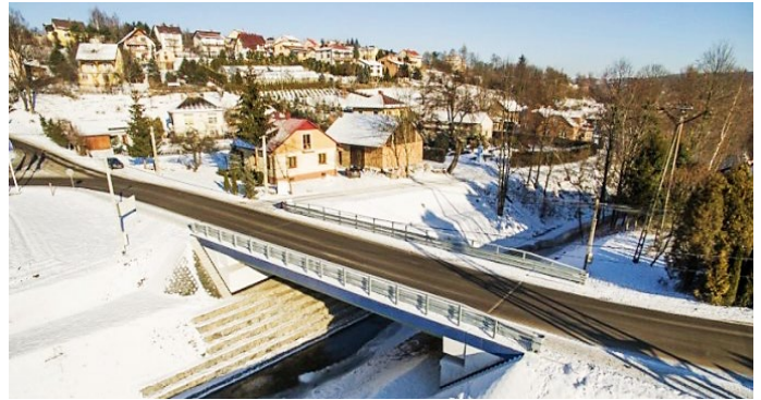
Pierwszy polski most drogowy z kompozytów polimerowych wzmacnianych włóknami szklanymi i węglowymi, fot. Mostostal Warszawa SA
