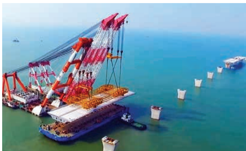
Montaż sekcji mostu, fot. HZMB
