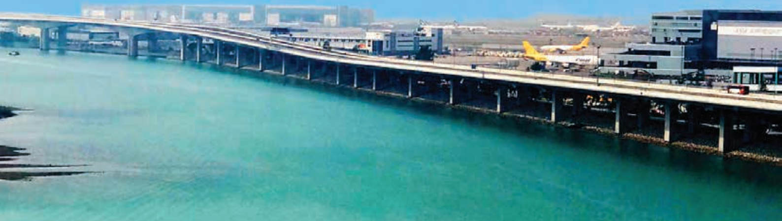
Estakada wzdłuż lotniska, fot. Krzysztof Dąbrowiecki
