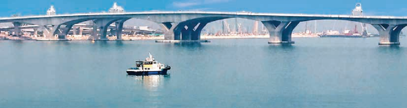
Estakada prowadząca do mostu, fot. Krzysztof Dąbrowiecki
