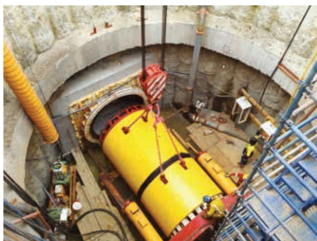
Ryc. 2. Uruchomienie MTBM z drugiego wiatu w Ghanie [3]
