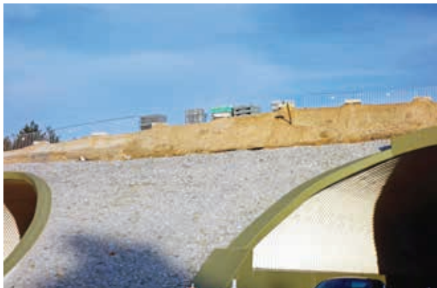
Ryc. 7. Przykład wykonywania umocnienia skarpy górnego przejścia dla dużych zwierząt z wykorzystaniem kostki kamiennej
