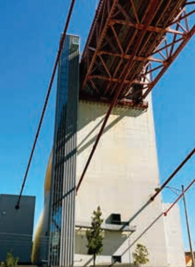
Filar 7 z blokami kotwiącymi dodatkową parę lin nośnych
