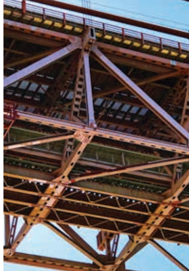
Dźwigar nośny z widocznymi cięgami powietrznymi
