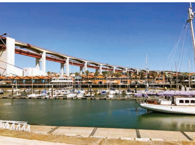
Estakada po stronie północnej
