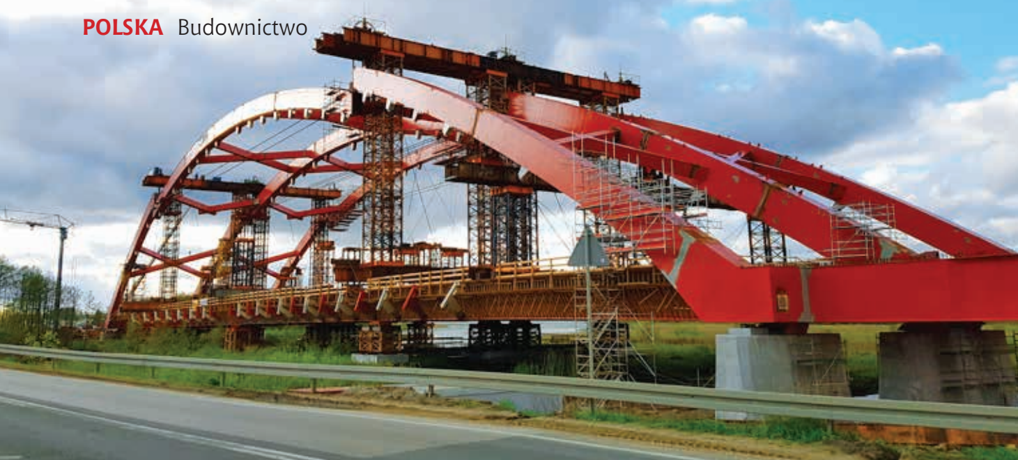
Podnoszenie elementów tuku mostu MS-4B w ciągu S7 nad kanałem Pauzeńskim
