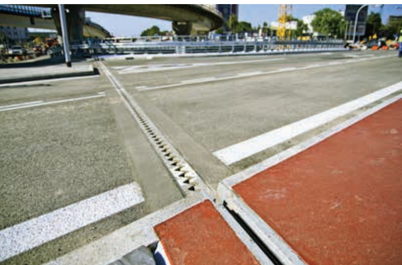
Dylatacja modułowa 3W z nakładkami wyciszającymi
