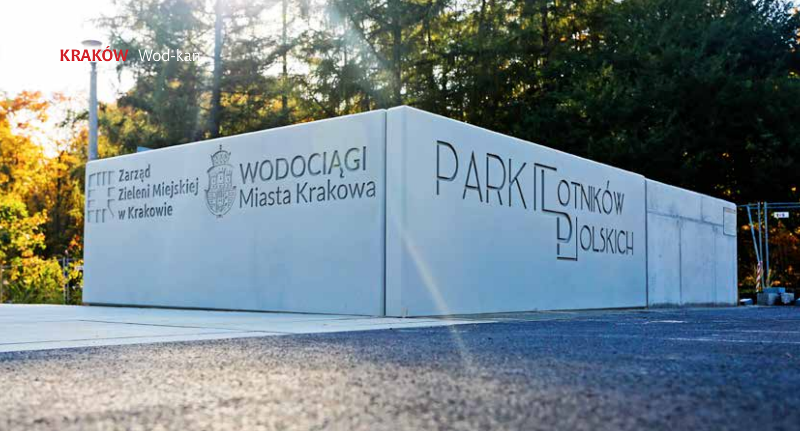
Mur z logo parku, w ścianie którego znajduje się niewidoczny dla postronnego obserwatora wlot powietrza do komory wentylacji fontanny
