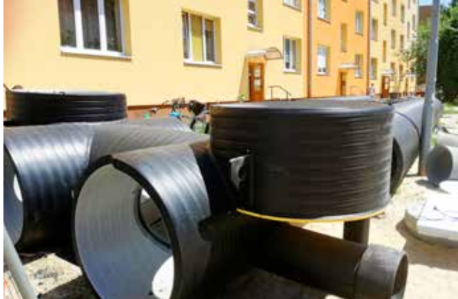
Budowa retencyjnego kanału ściekowego w Mielcu
