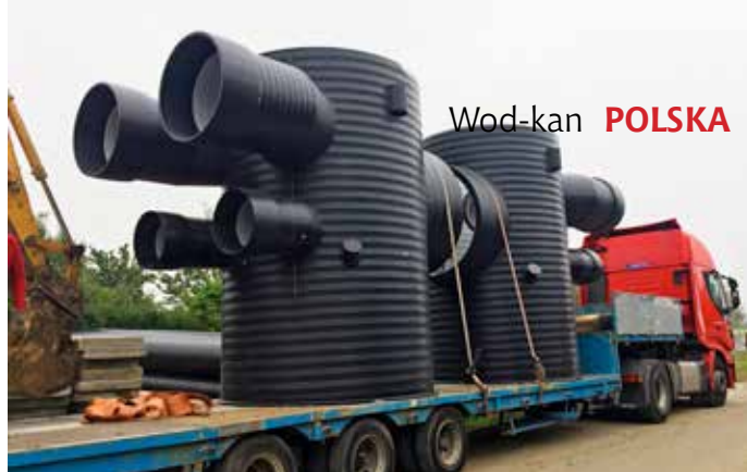
Dostawy elementów retencyjnego kanału ściekowego na os. Budziwój w Rzeszowie
