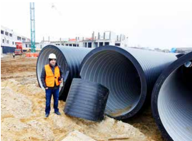
Rury strukturalne Weholite z PE-HD przygotowane do budowy kanału retencyjnego na os. Krakowska Południe w Rzeszowie
