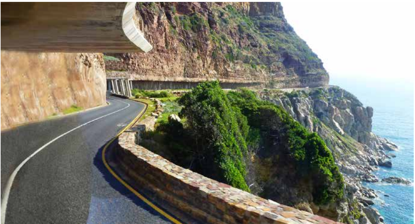
Ryc. 3. Fragment Chapman's Peak Drive z widocznym półtunelem
