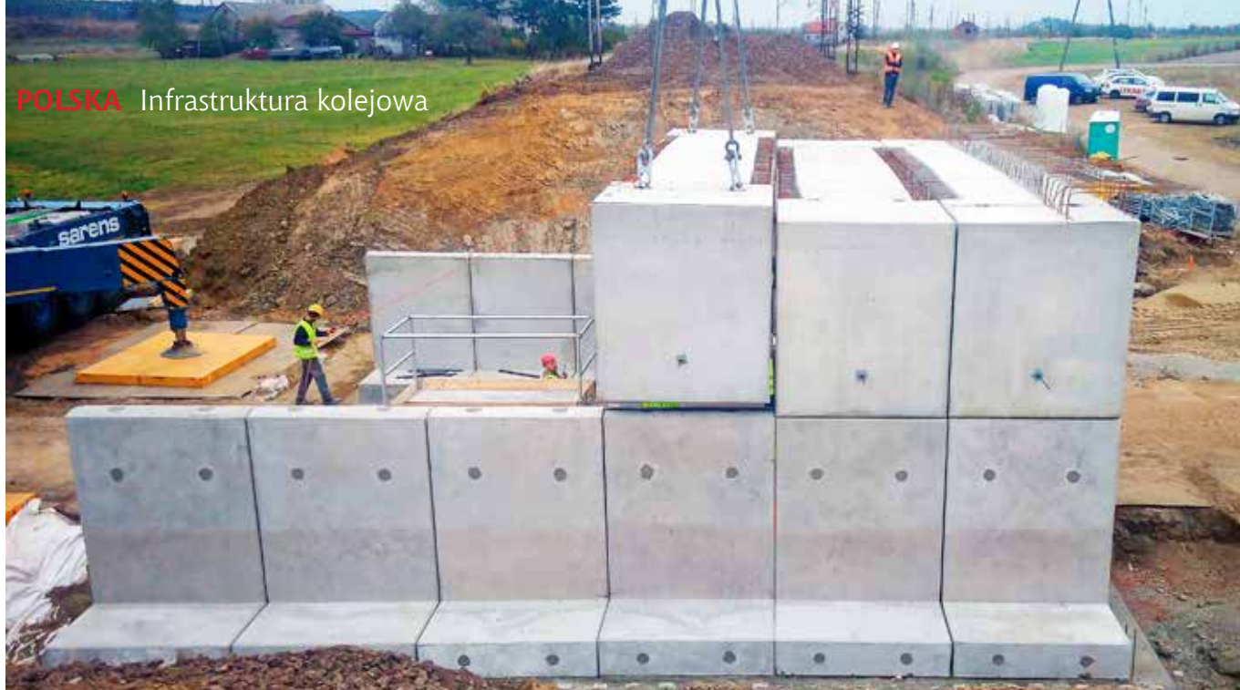
Ryc. 2. Montaż elementów ramowych na wcześniej ustawionych podporach
