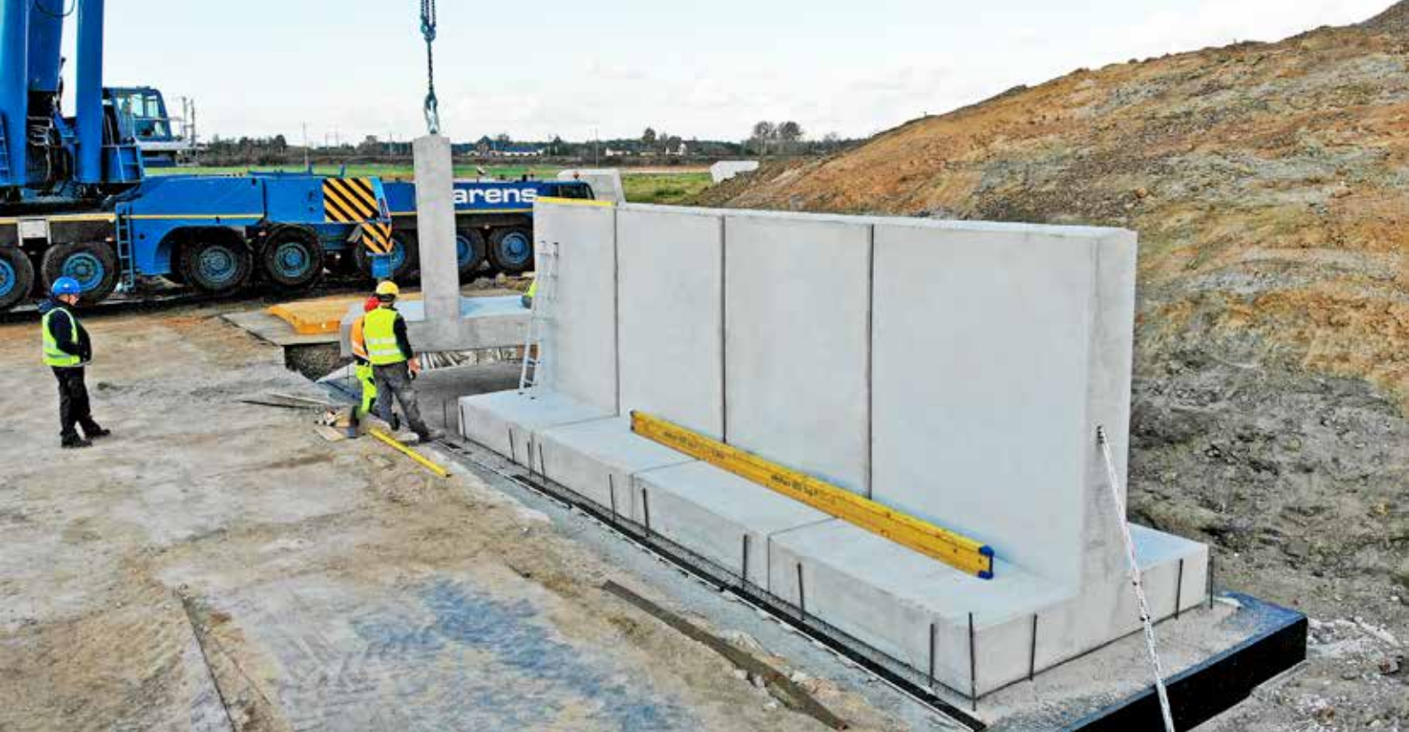
Ryc. 1. Montaż ścian podporowych
