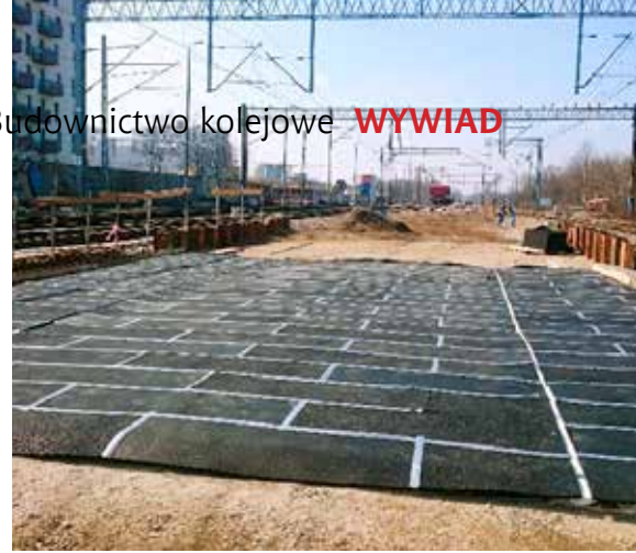
Układanie mat przeciw wibracyjnym na obiekcie inżynieryjnym, fot. archiwum Strabag
