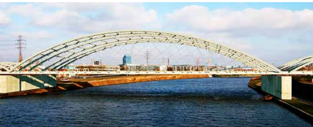
Mosty kolejowy przez Wisłę w Krakowie – stan istniejący i wizualizacja obiektu po budowie i przebudowie, fot. nbimedia oraz archiwum Strabag
