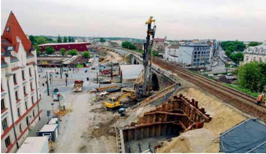
Kraków, widok na budowę estakady E1, przebudowę zabytkowego wiaduktu nad ul. Grzegórzecką oraz estakadę E2 (850 m), fot. archiwum Strabag
