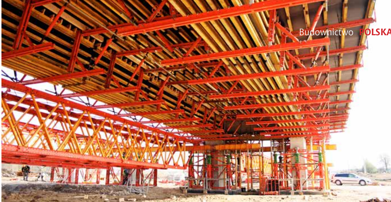
Ryc. 2. Podwieszane deskowanie Vario w trakcie przesuwu kratownic VRB
