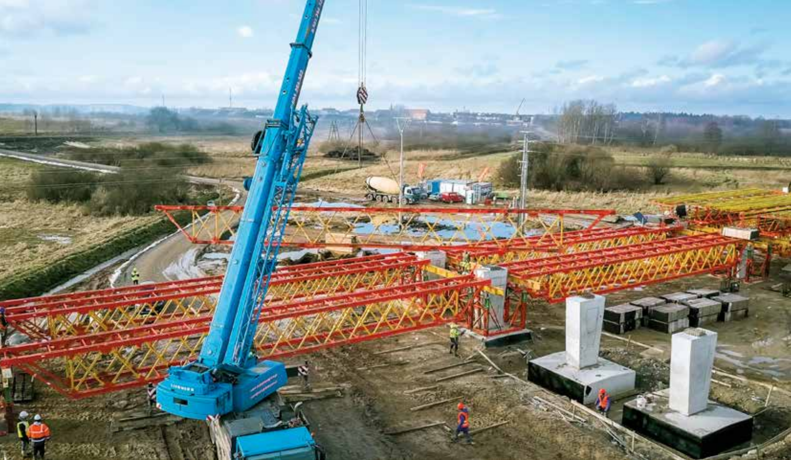
Ryc. 1. Montaż scalonych zestawów kratownic VRB na wieżach podporowych VST
