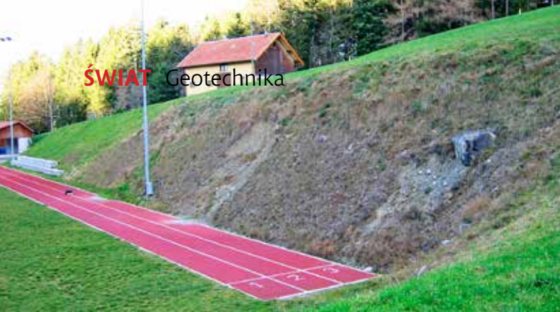
Ryc. 2. Miejscowe osuwanie się zbocza na terenie obiektu sportowego
