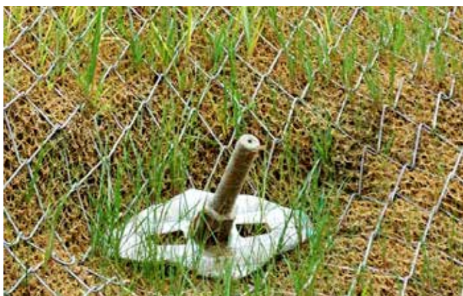
Ryc. 11. Mata antyerozyjna Tecmat w połączeniu z siatką z drutu stalowego o wysokiej wytrzymałości na rozciąganie Tecco® G65/3 na obszarze gwoździowania gruntu
