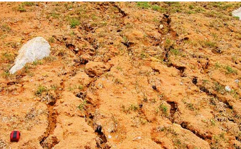
Ryc. 4. Kanaly erozji wywołane efektem płynięcia odprowadzanej wody, które powodują wyplukiwanie gleby i zmniejszają bądź nawet uniemożliwiają wzrost roślin
