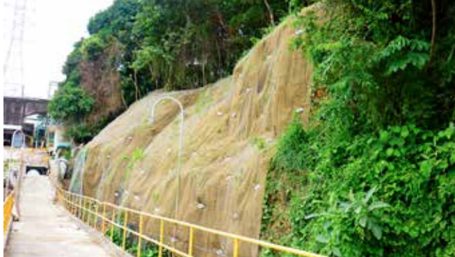
Ryc. 12. Zabezpieczona skalista skarpa w Miraflores w Panamie. Matę zabezpieczającą przed erozją i siatkę mogły się łatwo dopasować do nieregularnego zbrocza
