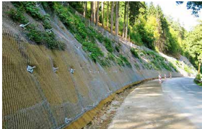
Ryc. 5. Stabilizacja skarp za pomocą siatki stalowej o wysokiej wytrzymałości na rozciąganie i maty antyerozyjnej (system Tecco® G65/3)
