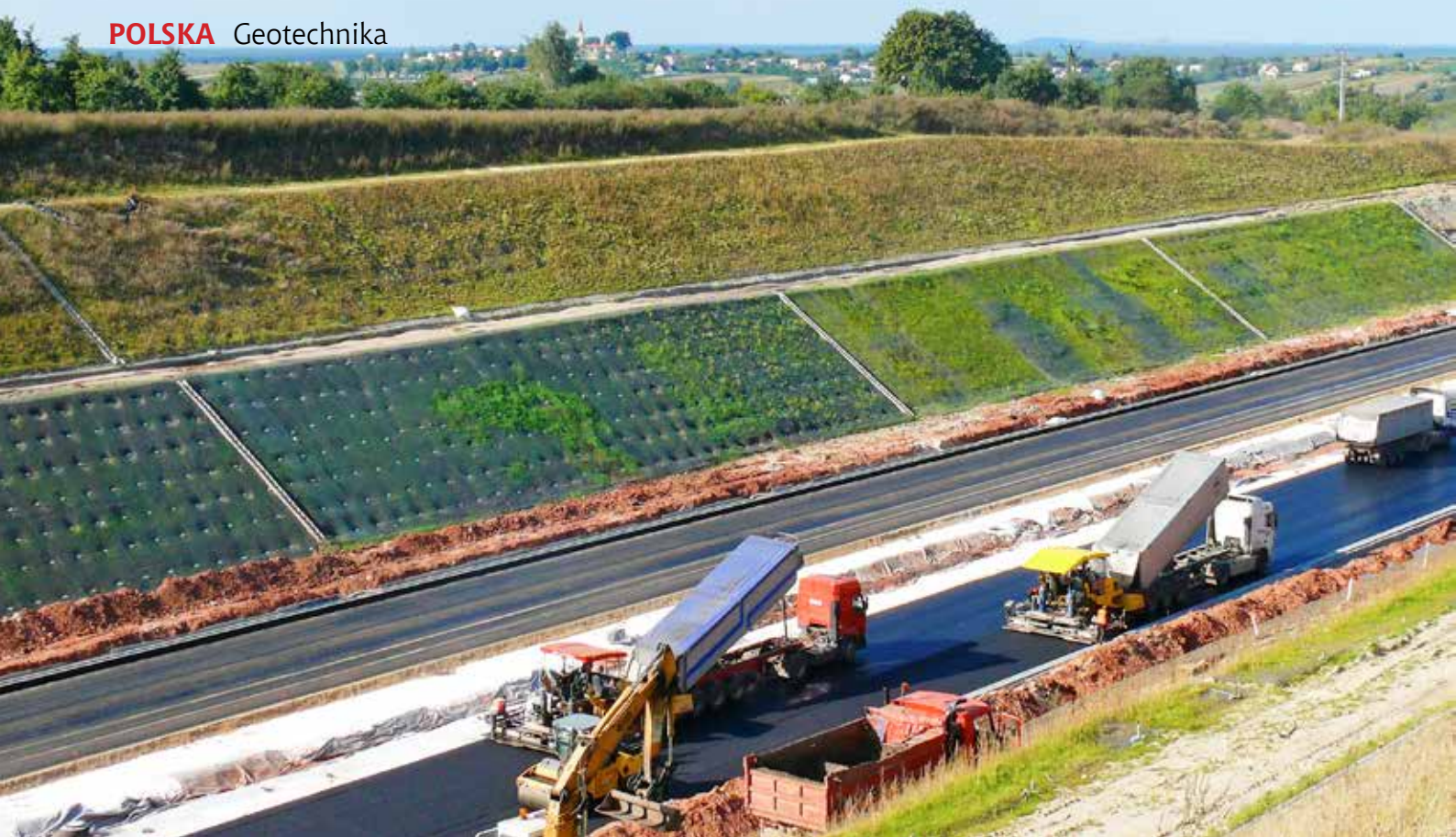
Ryc. 5. Prawidłowo zrealizowana skarpa gwoździowana, widoczne różne etapy rozwoju traw, na górnych poziomach gwoździe gruntowe całkowicie ukryte w warstwie roślinnej
