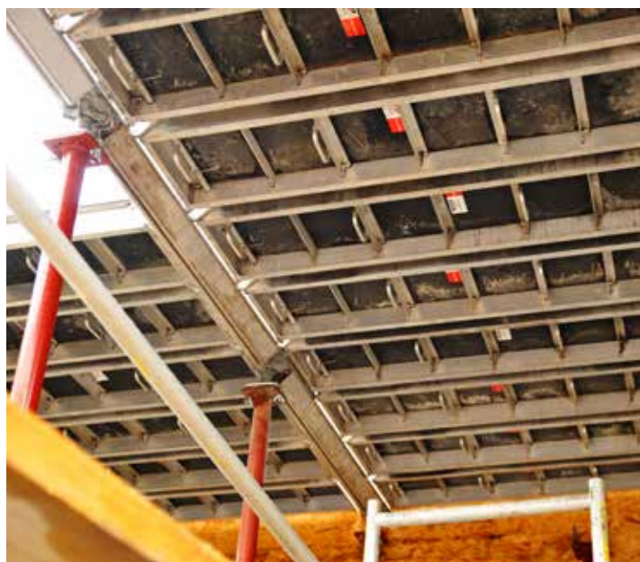
Widok typowego układu pola roboczego deskowania z zastosowaniem paneli HV
