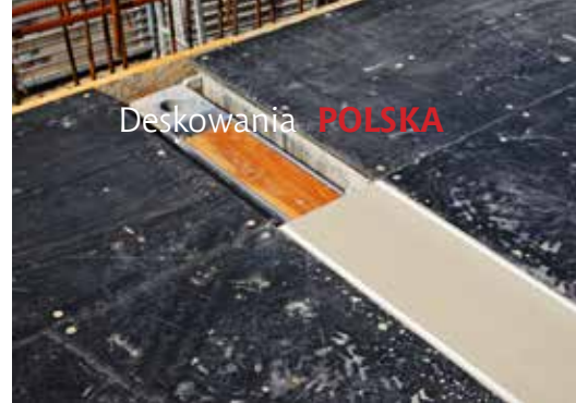
Powierzchnia deskowania – systemowe pasy uzupełniające wypełniające przerwy między panelami
