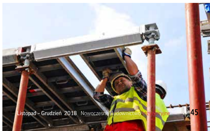
Układanie paneli HV na dźwigarach
