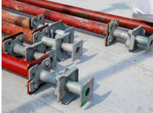
Główce opadowe zamontowane wstępnie na podporach
