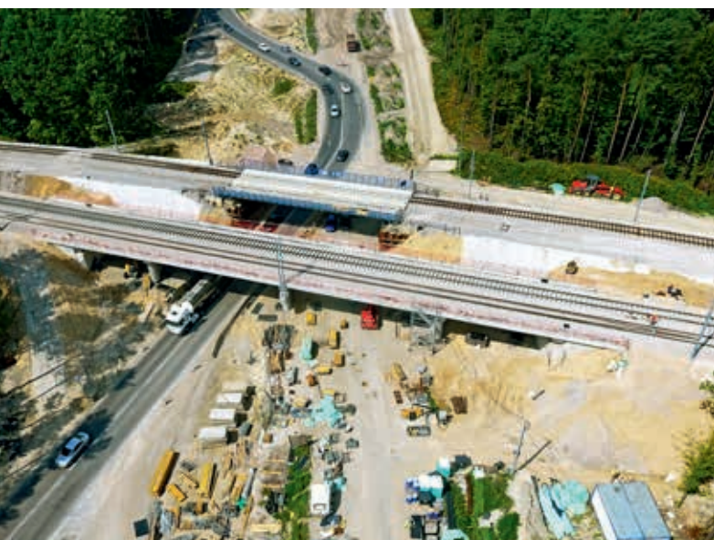
Roboty torowe na obiekcie WK-1 w km 39 + 417, odcinek Kolbiel – Garwolin, fot. J. Grzejszczak
