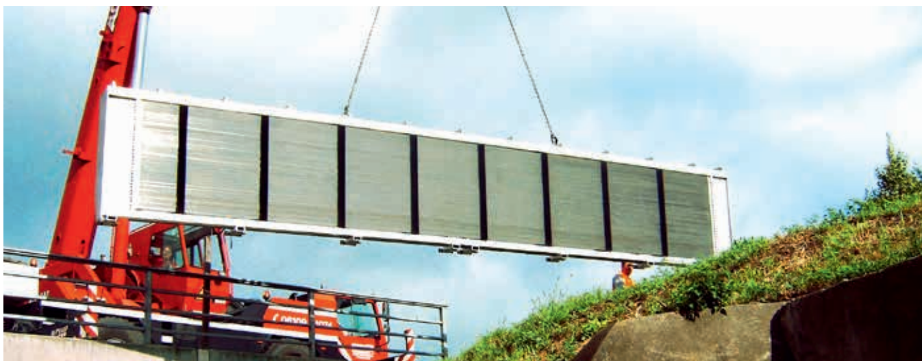
Montaż kraty HSR-Screen na przelew burzowy, fot. HST Systemtechnik GmbH & Co. KG
