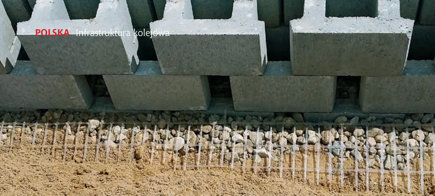
Mur oporowy w trakcie realizacji – widok od strony zasypki muru
