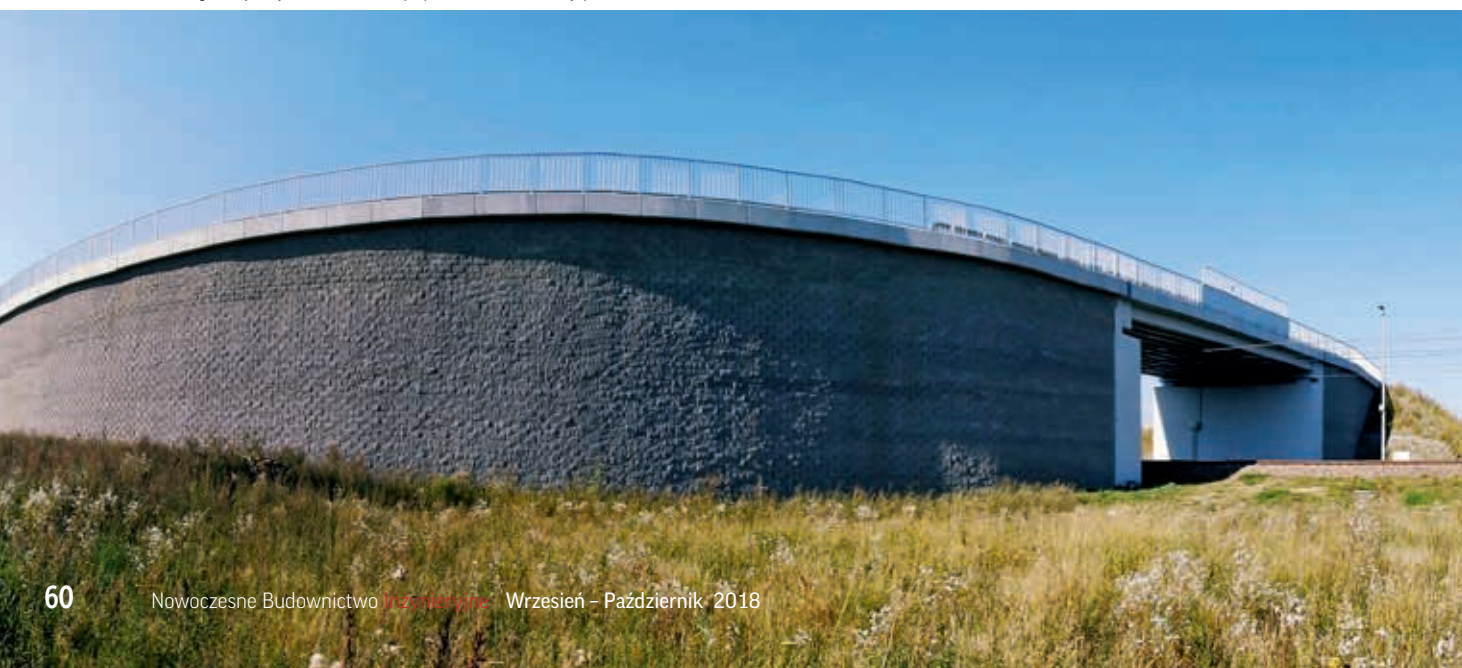
Dłgie dojazdy do wiaduktów poprowadzone zostały po łuku
