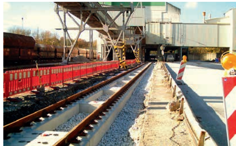
Ryc. 9. Nawierzchnia kolejowa bezpodсыpkowa NFF po wykonaniu, Kalkwerk Wülfrath
