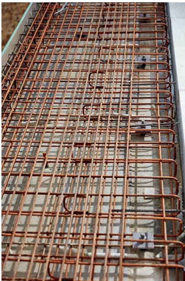
Ryc. 2. Zamontowane kotwy przed betonowaniem kapy
