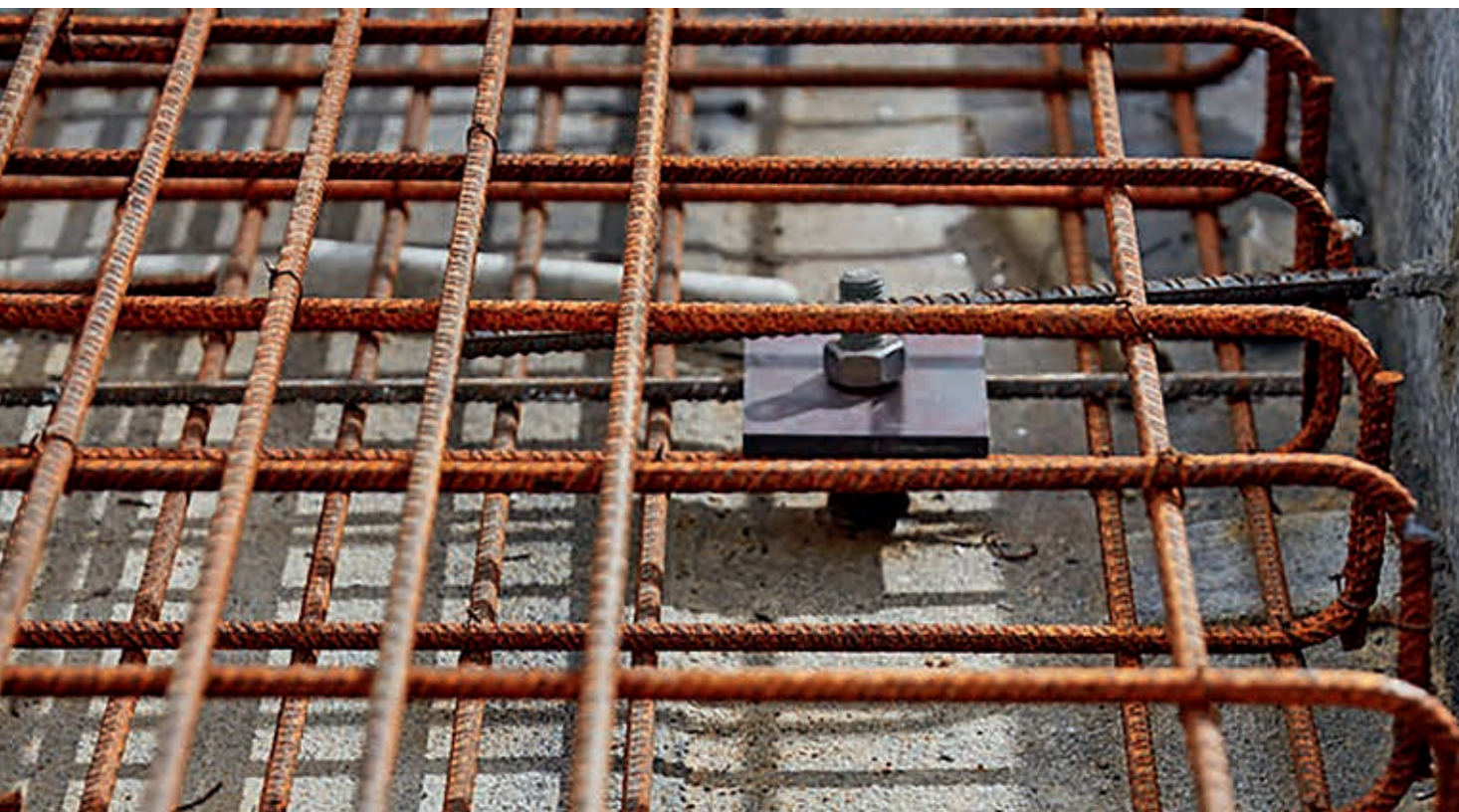
Ryc. 3. Wklejana kotwa kapy chodnikowej
