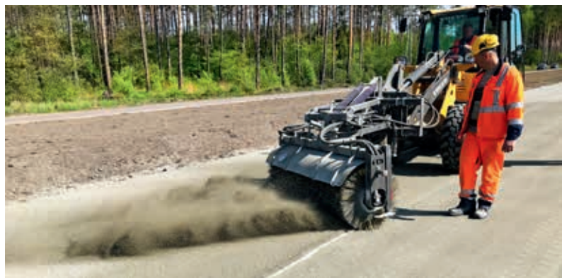
Usuwanie zaprawy cementowej
