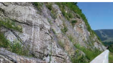
Dostawa i montaż siatki heksagonalnej w m. Tresna
