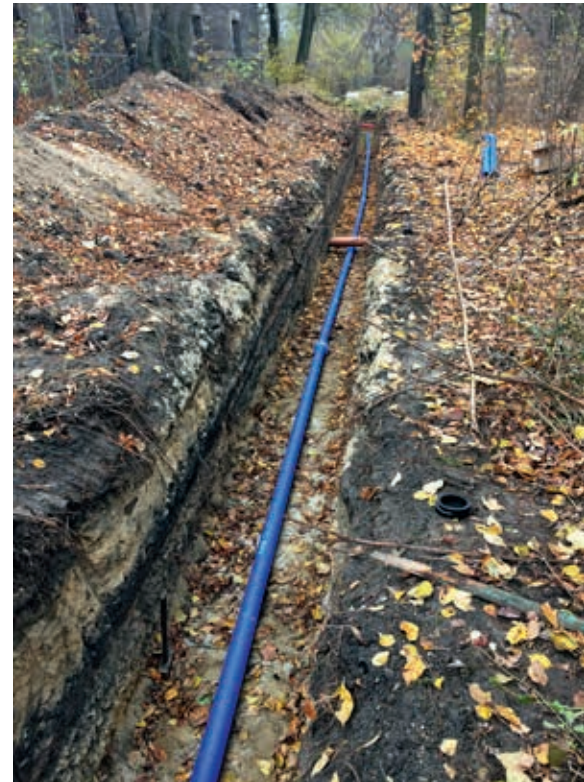
Realizacja sieci wodociągowej przez PWiK Gliwice za pomocą systemu BLUTOP®. System BLUTOP® to lekkie rury ze zwiększonym przekrojem hydraulicznym i kształtki z żeliwa sferoidalnego dla małych średnic, dzięki czemu możliwy jest ręczny montaż bez użycia jakichkolwiek maszyn. Zwiększona średnica wewnętrzna rur oznacza większą pojemność sieci wodociągowej, znaczną redukcję strat hydraulicznych na długich odcinkach rurociągu i mniejsze koszty pompowania. System jest dostępny w średnicach od DN/OD 75 do DN/OD 160
