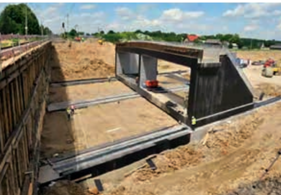
Budowa drogi S19 Lubartów – Kraśnik z zastosowaniem metody przecisku ramy dwukomorowej
