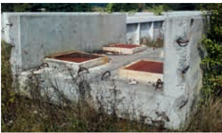
Prefabrykowane bloki podłożyskowe pod konstrukcją odciążającą
