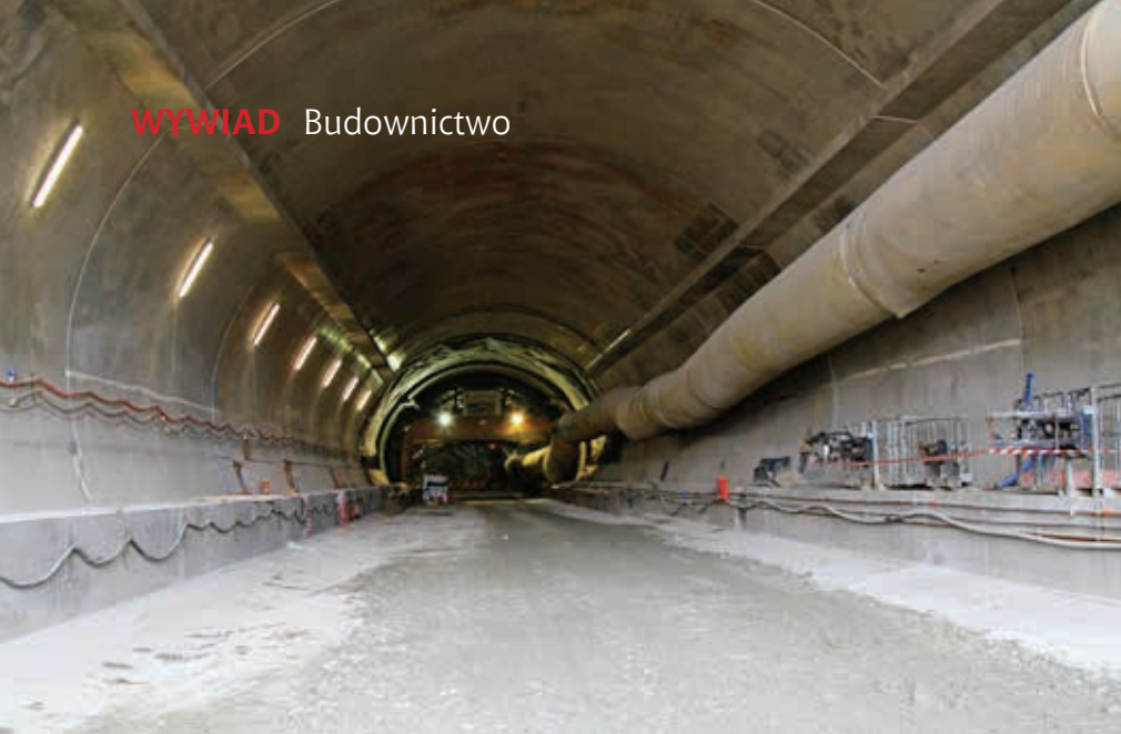
Prace przy drążeniu tunelu od strony portalu północnego w Naprawie, fot. NBI Media
