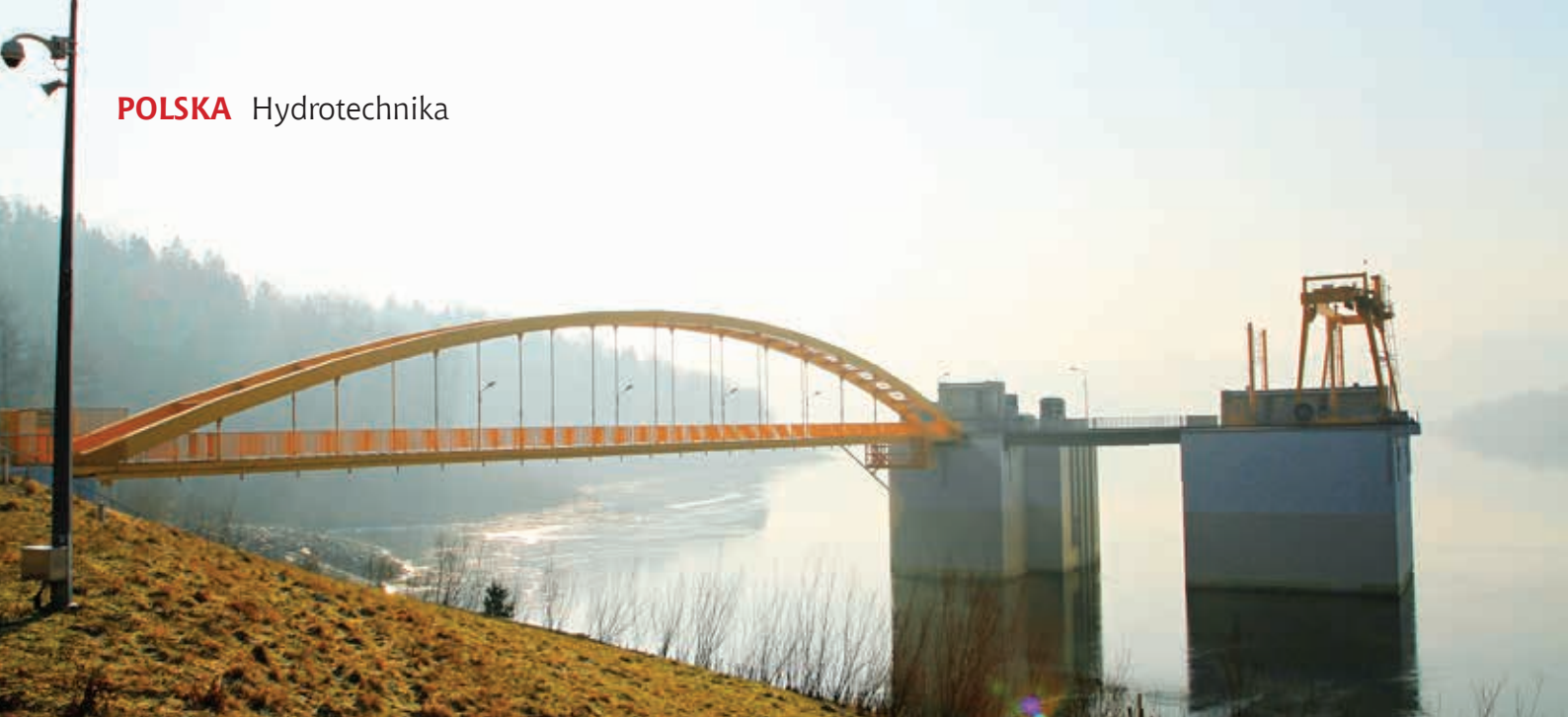
Wieża zamkniętej sztolni spustowej oraz wieża sztolni energetycznej
