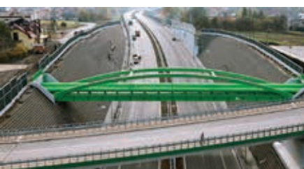
Dostawa i montaż gabionów – Budowa obwodnicy Bielsko Białej
