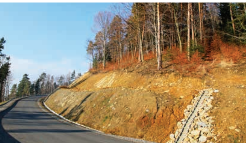
W ramach inwestycji wybudowano drogi na trudnych terenach osuwiskowych
