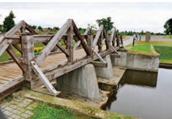
Drewniany most nad tamą koło zamku w Mirze (obiekt nr 11)
