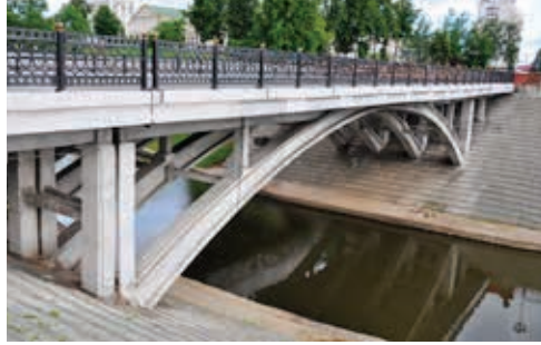
Łukowy most betonowy przez rzekę Wićbę w Witebsku (obiekt nr 24)
