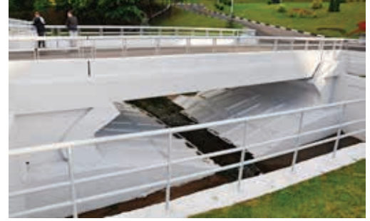
Żelbetonowy most płytowy w Słowiańskim Bazarze (obiekt nr 25)
