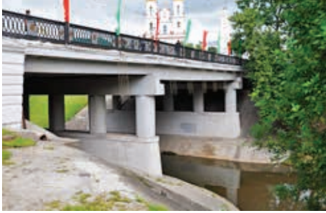
Żelbetowy most belkowy przez rzekę Wićbę w Witebsku (obiekt nr 22)
