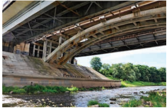
Hybrydowy most stalowo-betonowy przez Łuczesę w Witebsku (obiekt nr 19)
