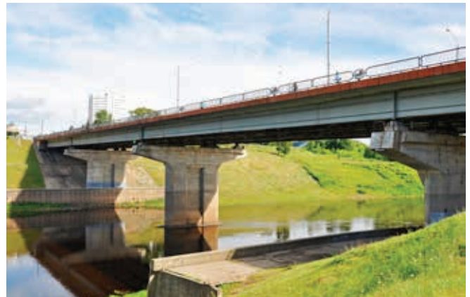
Stalowy most belkowy przez Dźwinę w Witebsku (obiekt nr 20)
