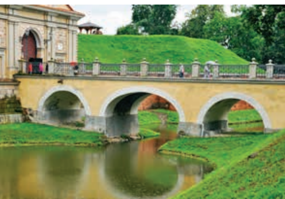
Kamienny most łukowy nad fosą do zamku Radziwiłłów w Nieświeżu (obiekt nr 12)
