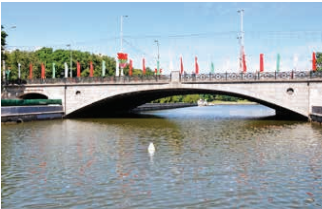
Żelbetonowy most łukowy przez Świsłocz w Mińsku (obiekt nr 15)
