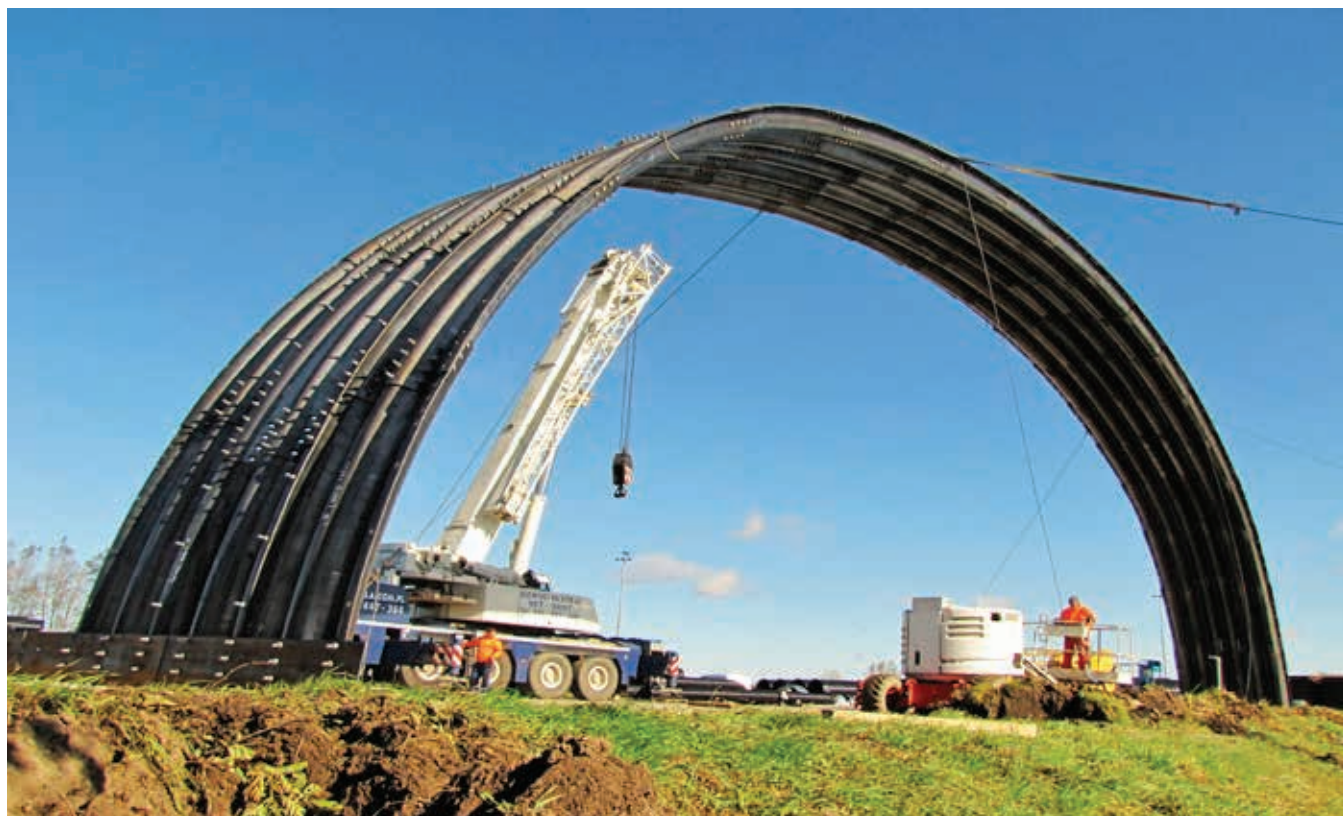
Ryc. 7. Montaż konstrukcji o dużej sztywności fali i dużych rozpiętościach
