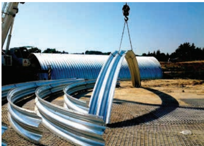
Ryc. 5. Przykład montażu z częściową prefabrykacją
