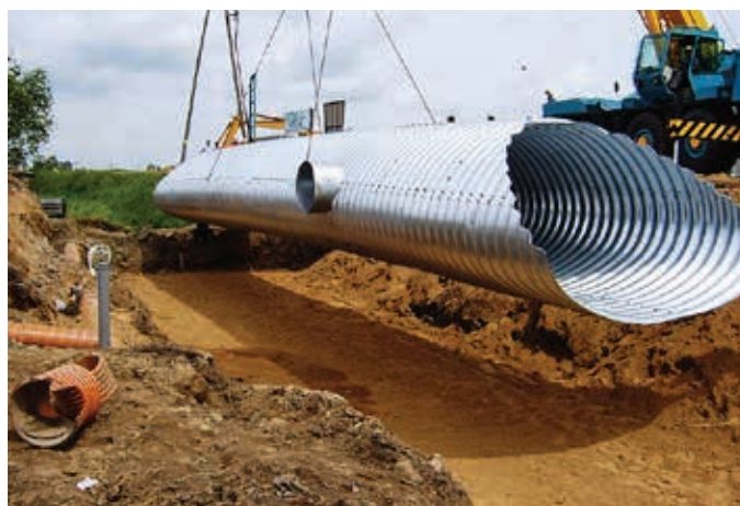
Ryc. 6. Przykład montażu z pełną prefabrykacją
