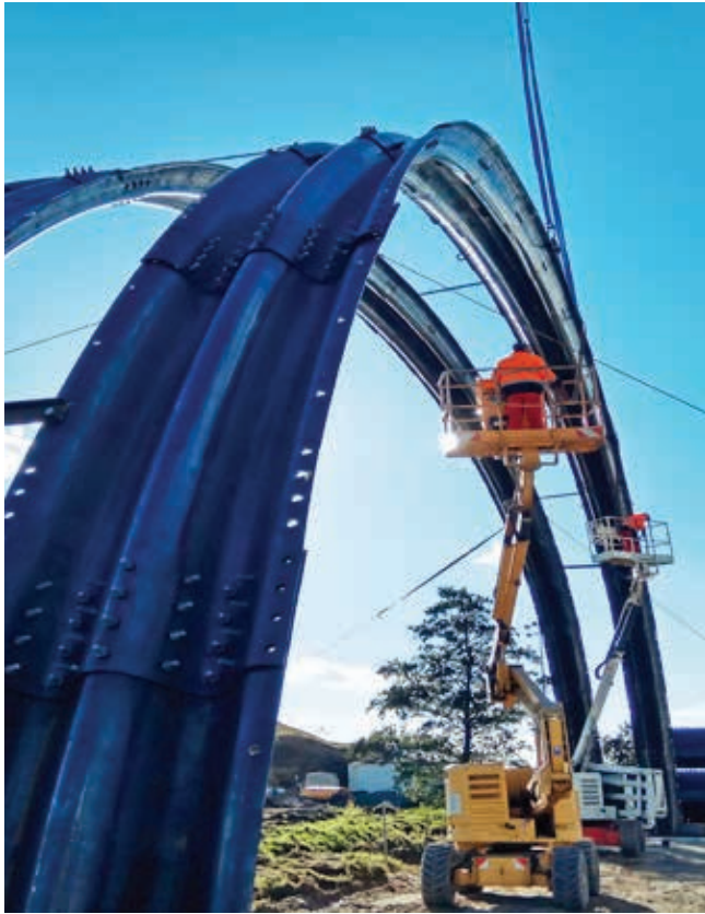
Ryc. 8. Sposób montażu konstrukcji o karbowaniu 500 x 237 mm
