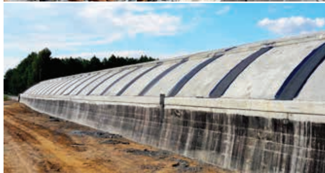
Ryc. 7 i 8. WS-19A – węzeł uciągający przed zabetonowaniem oraz obiekt w trakcie realizacji (widoczna górna płyta zespalająca)
