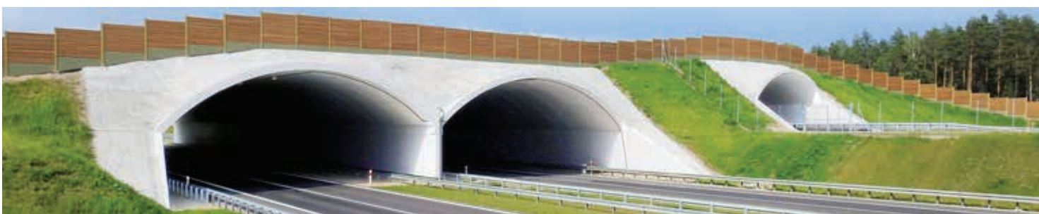
Ryc. 22. Obiekt PE-1.1 w trakcie eksploatacji
