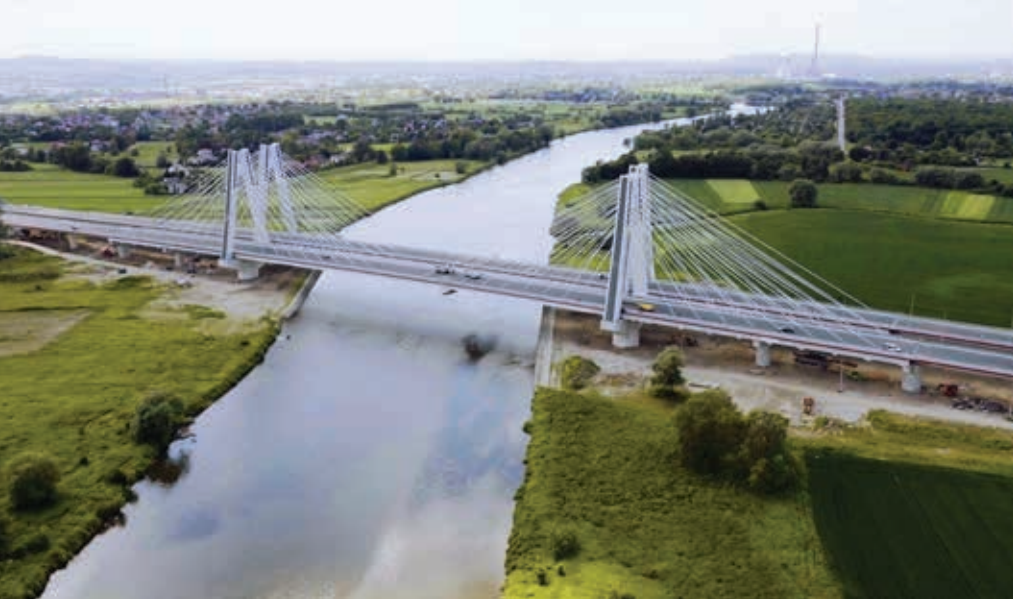
Odcinek S7 wraz z najdłuższym w Małopolsce mostem przez Wisłę w Krakowie
