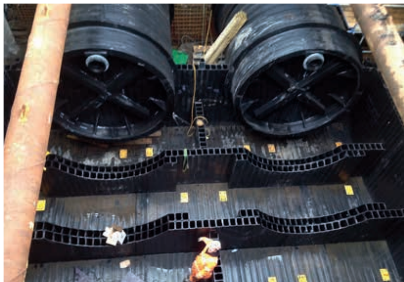
Montaż komór z użyciem rur i paneli PE-HD Weholite
