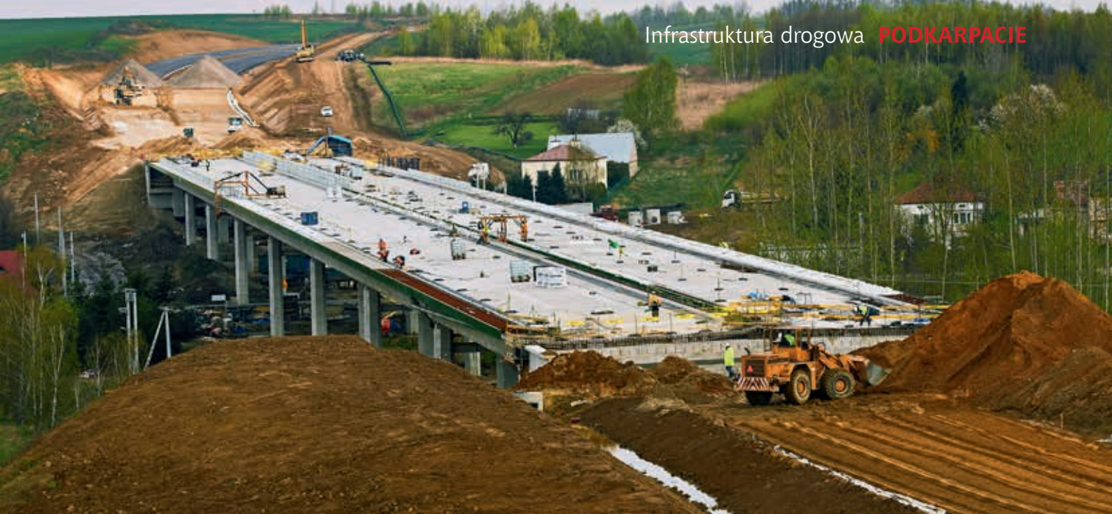
Budowa estakady E1 (Rzeszów, ul. Dębicka)
