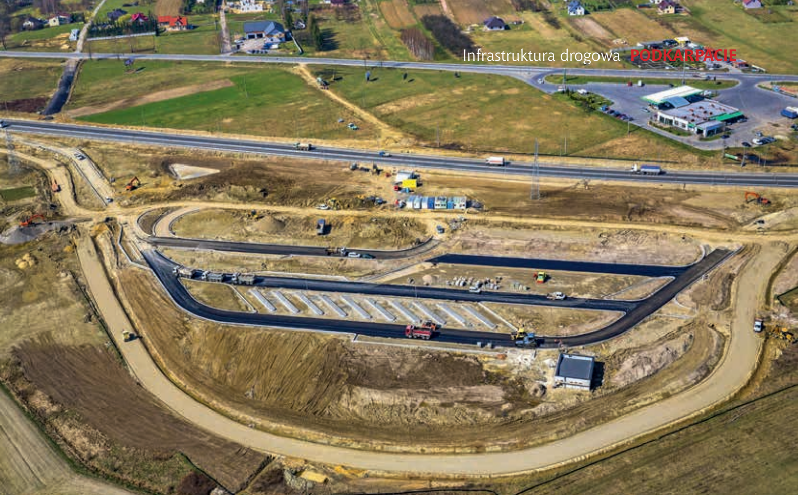
Budowa MOP Stobierna
