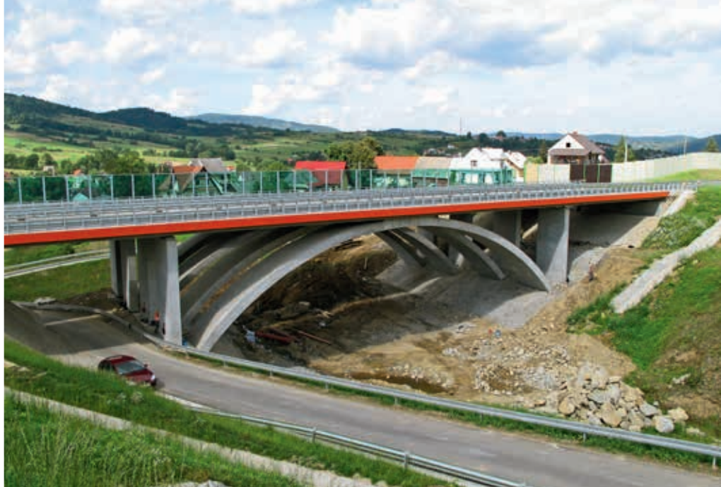
Wiadukt w ciągu obwodnicy miejscowości Lubień
