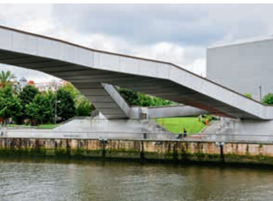
Kładka Pedro Arruque (obiekt nr 15)
