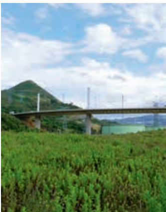
Widok mostu La Arena (obiekt nr 24)
