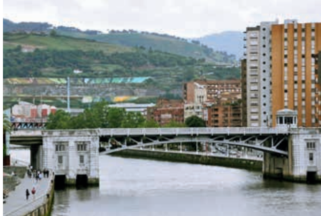
Most Duesto (obiekt nr 16)
