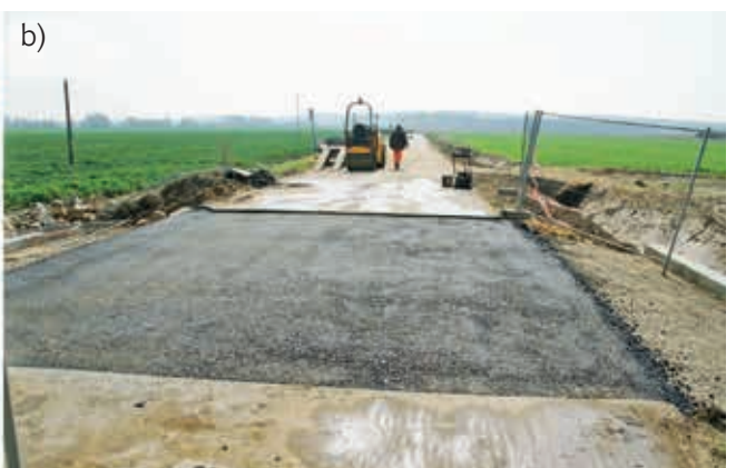
Ryc. 14. Przykład wykonywania nawierzchni nad konstrukcją przepustu skrzynkowego: a) widok etapu wykonywania warstw podbudowy pod nawierzchnią, b) widok wykonanej warstwy wiążącej na obiekcie, fot. A. Wysokowski
