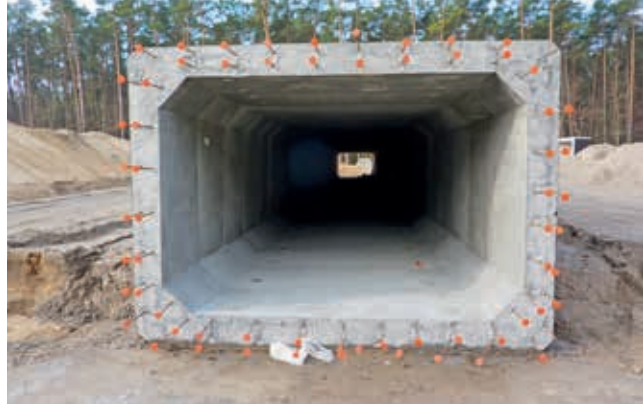
Ryc. 3. Widok skrajnego prefabrykatu o przekroju skrzynkowym. Widoczne wypuszczone zbrojenia zespalające głowicę z zasadniczą konstrukcją przepustu, fot. A. Wysokowski
