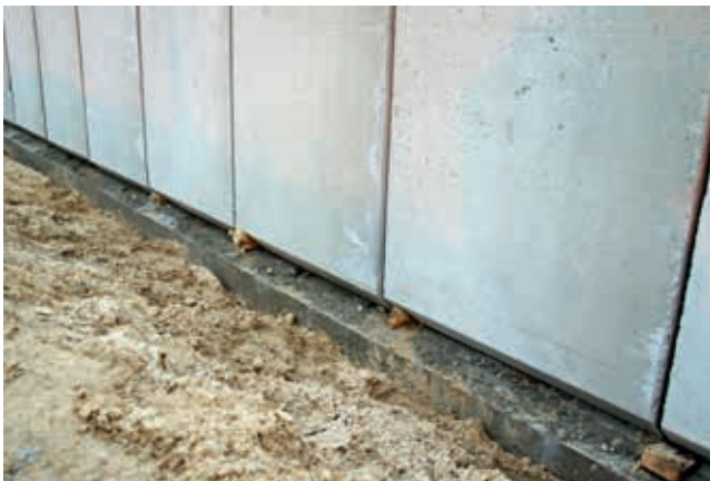
Ryc. 2. Widok prefabrykatów po etapie montażu na przygotowanej uprzednio płycie fundamentowej, fot. A. Wysokowski
