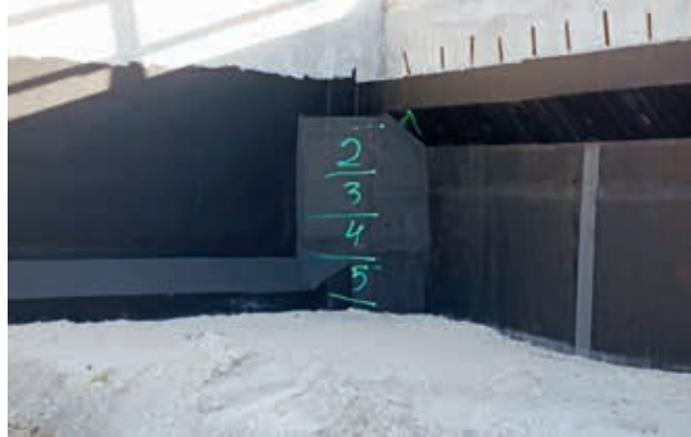
Ryc. 9. Widok zasypki konstrukcyjnej przepustu skrzynkowego w trakcie jej wykonywania. Widoczne technologiczne zaznaczenie miąższości poszczególnych warstw na wewnętrznym elemencie skrzydełka, fot. A. Wysokowski
