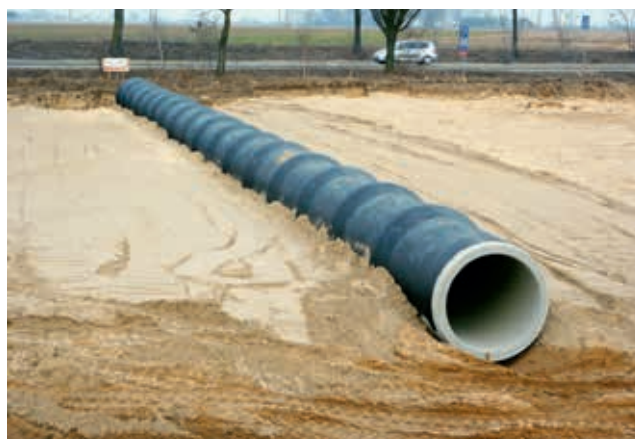
Ryc. 10. Widok wykonywania wstępnego etapu zasypki dla przepustu prefabrykowanego o przekroju kołowym, fot. A. Wysokowski
