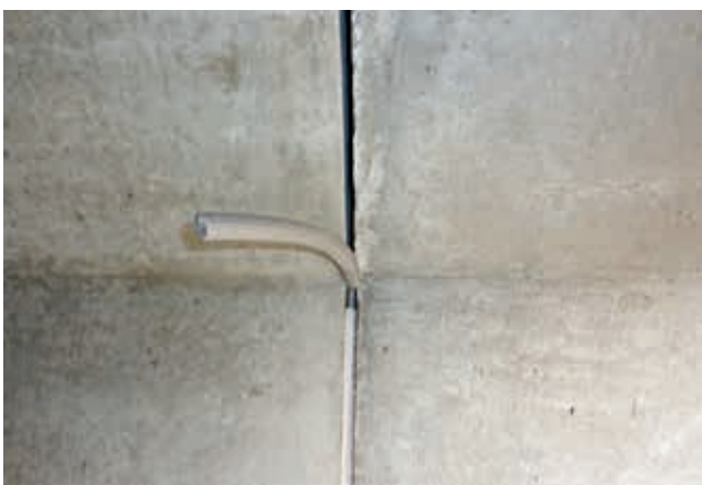
Ryc. 8. Widok jednego z elementów uszczelnienia segmentów prefabrykowanych w postaci uszczelki z materiału trwale plastycznego, fot. A. Wysokowski
