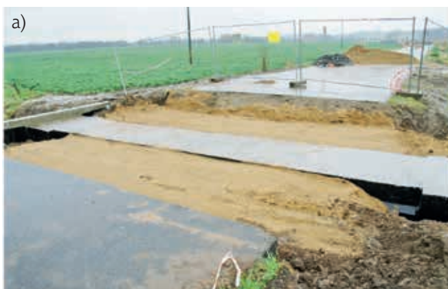
Ryc. 14. Przykład wykonywania nawierzchni nad konstrukcją przepustu skrzynkowego: a) widok etapu wykonywania warstw podbudowy pod nawierzchnią, b) widok wykonanej warstwy wiążącej na obiekcie, fot. A. Wysokowski
