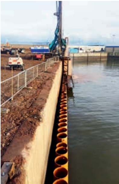
Montaż palościanki RD® w porcie rybackim Peterhead
